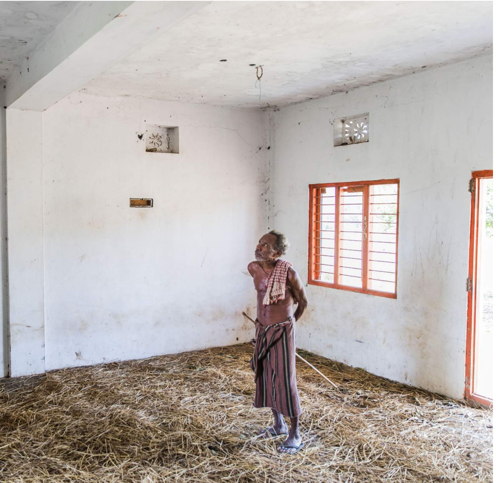
Pedersen hevder, må rundt 100 barn bo i ett rom som dette
