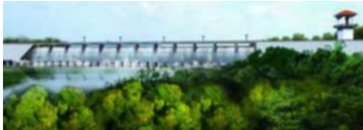
STRIDENS KJERNE: Amaila Falls-kraftverket skulle etter planen bli bygget i regnskogen, og ble kalt flaggskipet i partnerskapet mellom Norge og Guyana. Guyanske myndigheter ønsker ikke lenger å gjennomføre byggingen av prosjektet med en totalpris på mer enn seks milliarder kroner. FOTO: SITHE GLOBAL
