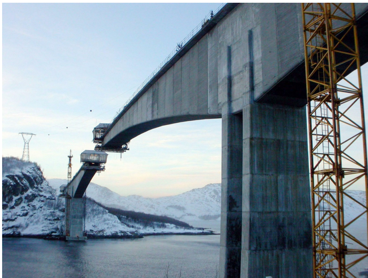
Dette bildet tok jeg som journalist i Helgelands Blad, under bygginga av Sundøybrua, vinteren 2003.
