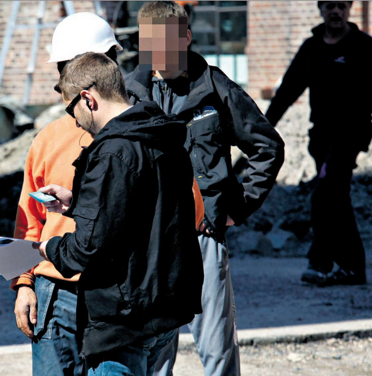
I går var det full sjekk av de ansatte ved byggeplassen på den nye Kunsthøgskolen i Oslo, men uten at noen ble tatt. Sist uke ble to mann med falsk ID pågrepet her.
