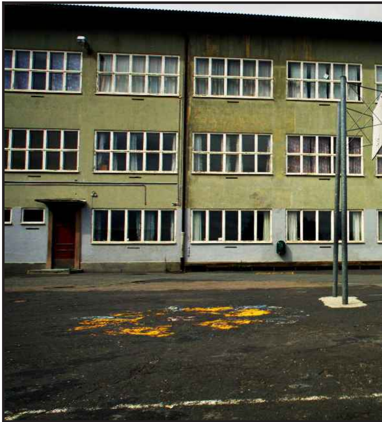
Forfallent: Smestad skole var nedslitt og forfallen da Anders Behring Breivik var elev. Dette bildet er fra 2001, før skolen ble pusset
