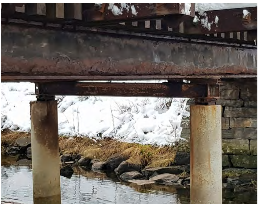
ETTER: Bærebjelken er midlertidig støttet opp. Foto: ARNOLD MATRE
