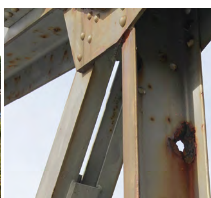
Foto: ØYVIND ENGAN
