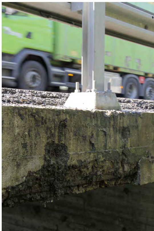
TUNGT TRAFIKKERT: Huldalskilen bro på E18 ved Kragerø har en rustskade i kategorien «kritisk for bæreevnen». Statens vegvesen mener at broen er trygg å kjøre på, tross skaden.
