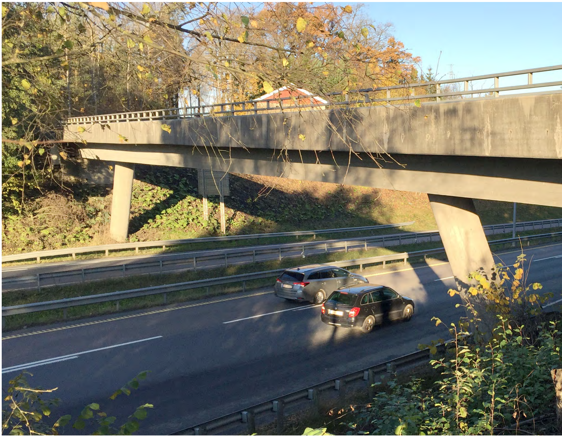
24 ÅR SIDEN: Denne 63 meter lange broen går over E6 i Ås kommune. Forrige gang den hadde hovedinspeksjon var i 1993, ifølge Brutus. – Dette er en enkel, robust betongbro bygget i 1991, Prestegarden, seksjonssjef bro i Statens vegvesen region øst. Foto: ØYVIND ENGAN
