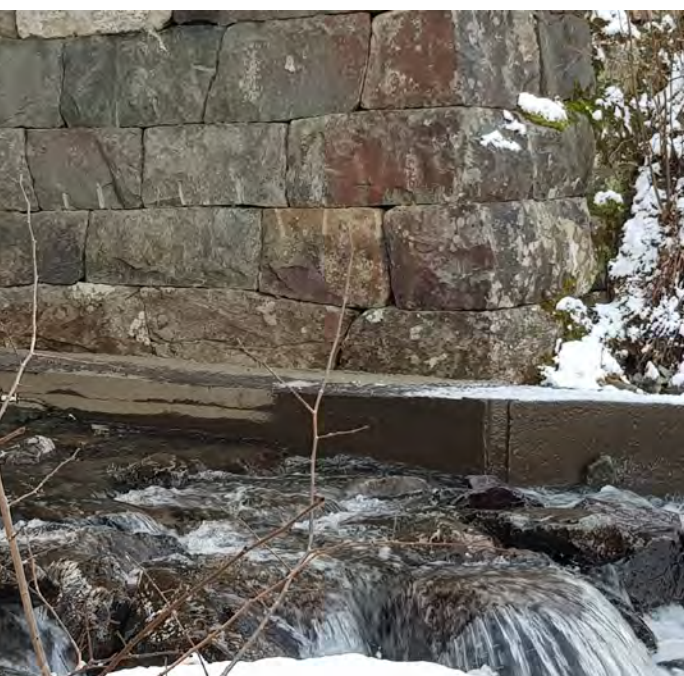
det støpt en kraftig betongkant nederst på landkaret. Foto: ASE
