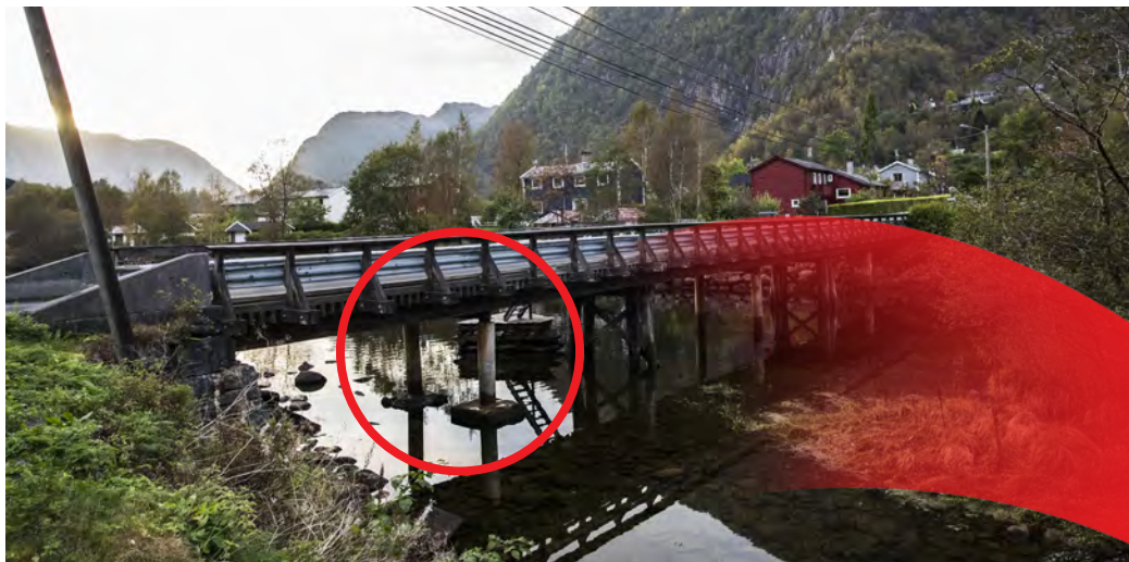
NOE FUNDAMENTALT GALT: Matredalen bro i Hordaland ble bygget i 1943, men er senere ombygget. Foto: HALLGEIR VÅGENES
