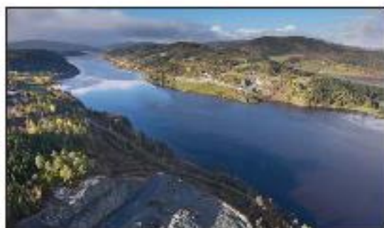
NY BRU: I denne traséen, over Beitstadsundet, kommer nye Fv. 17 mellom Asphaugen og Namsos. FOTO: JOHAN ARNT NESGÅRD
