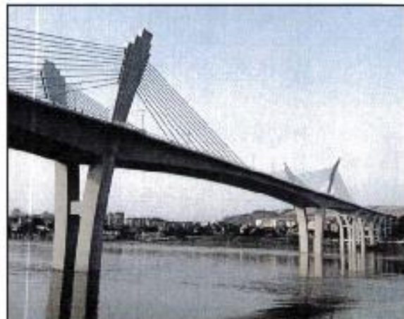
222 MILLIONER: Broen Luzhou Qiancao Langzuo i Sichuan-provinsen kostet 222 millioner kroner å bygge. Den ble satt opp av SRBG fra 2008 til 2012.
