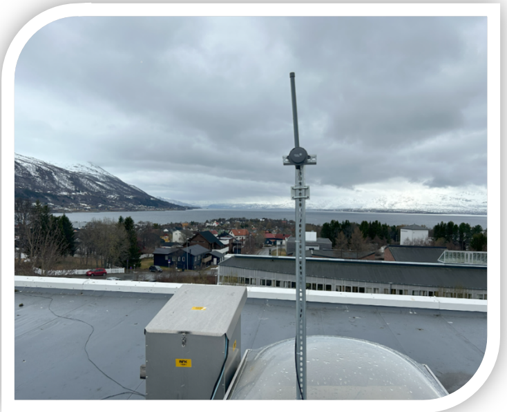
Figur 1 Antennen på taket hos NRK i Tromsø teller fartøy i området og dytter det videre til AISHub og andre nettverk
